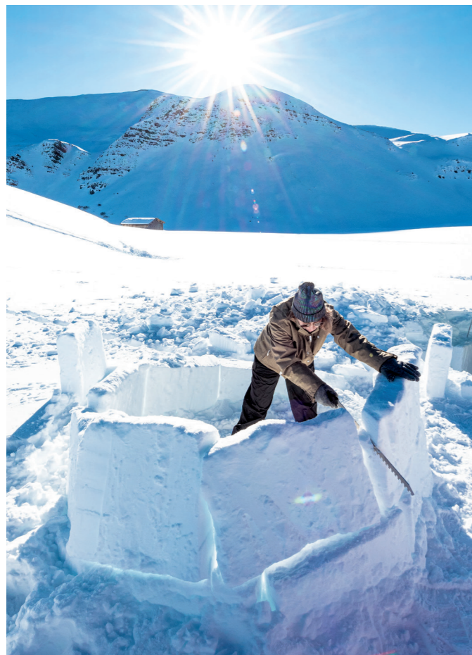
Block an Block: Spiralförmig geht es in die Höhe.
